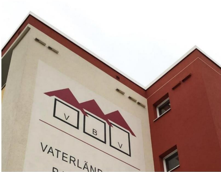
Umsetzungsbeispiel Nisthilfe für Mauersegler (Mauerseglernistkasten zum Einbau an Mauern)
