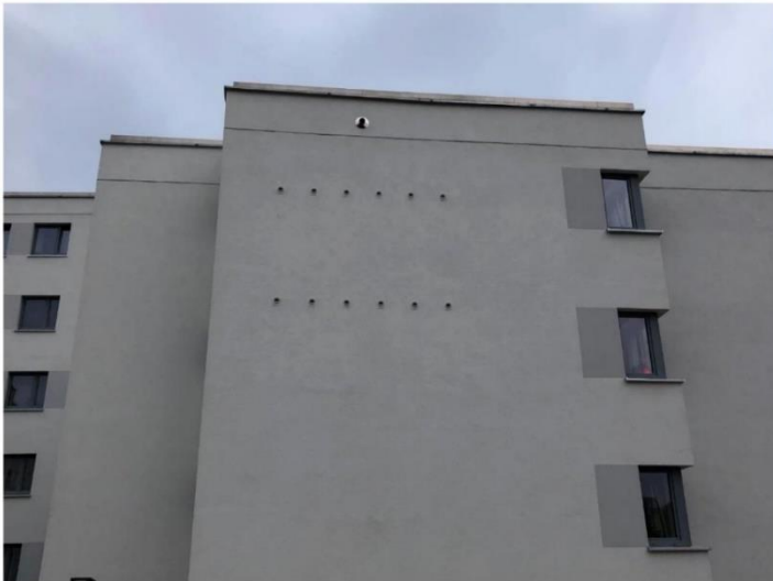
Umsetzungsbeispiel Nisthilfe für Haussperlinge (Nist- und Einbaustein in das Mauerwerk)
