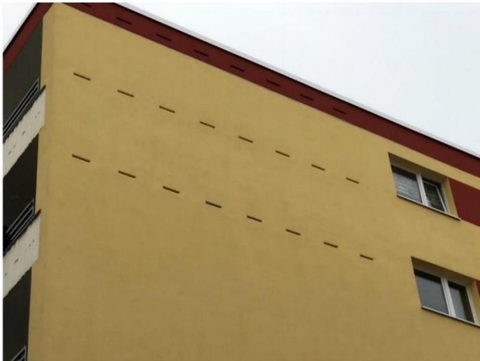
Umsetzungsbeispiel Nisthilfe für Fledermäuse (fassadenintegrierter Flachstein)
