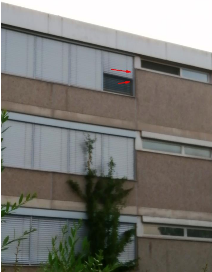
Abbildung 5: Einschluflbereich von der linken Seite aus.
