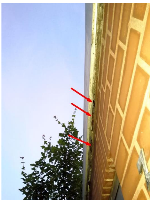
Abbildung 3: Spalt unter Attika
