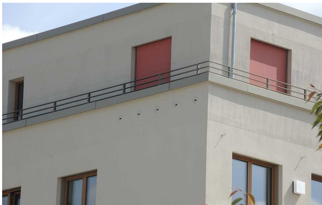
Abbildung 8: Beispiel einer Hausfassade mit integrierten Nisthilfen für Fledermäuse
