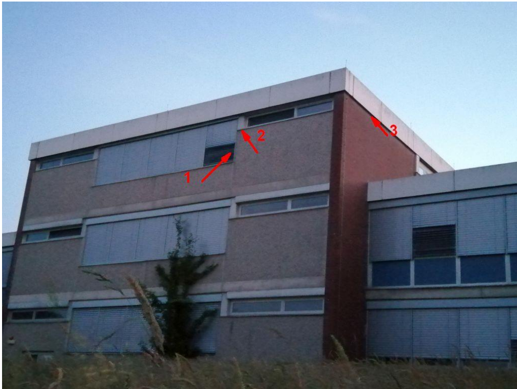
Abbildung 4: Gebäudeteil mit verschiedenen Quartierbereichen am Gebäuderiegel am Wilhelm-Busch-Weg.
