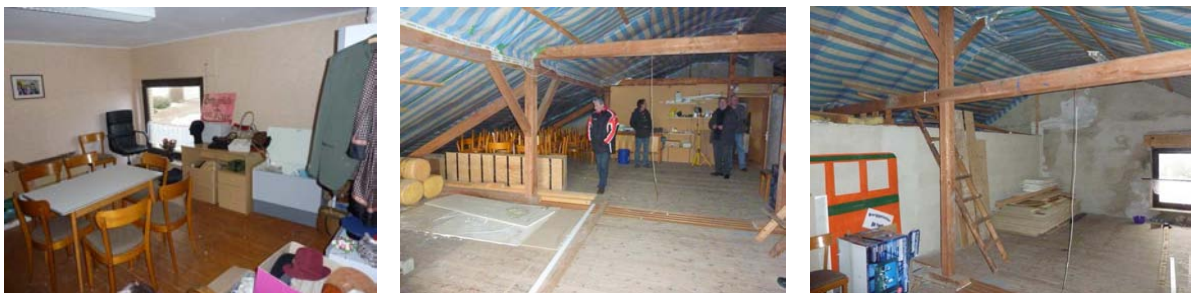
Abb. 12-14: Mehrzweckflächen im Dachgeschoss des DGH Goldbeck - Ausbau nicht abgeschlossen (Fotos: J. Koch, 2012)
