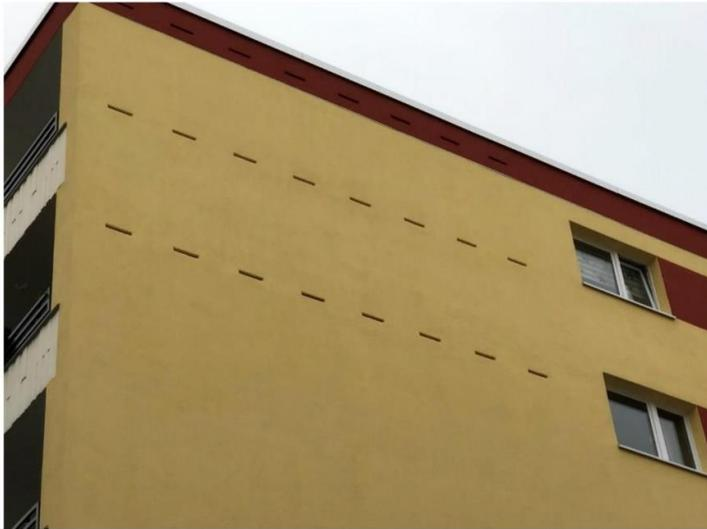
Umsetzungsbeispiel Nisthilfe für Fledermäuse (fassadenintegrierter Flachstein)
