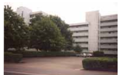
6. Mehrgeschosswohnungen westlich des Plangebietes
