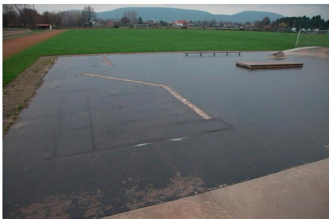
Abb. 2: Streifenfundamente der entfernten Holzrampen (16.12.2015)
