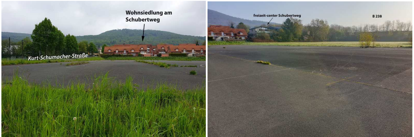
Abb. 2 Versiegelter Sportplatz (Tartan-Fläche) im nord-westlichen Teil des Plangebiets
