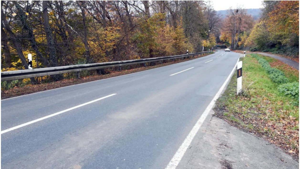
Blick Richtung Norden (11.2021)
