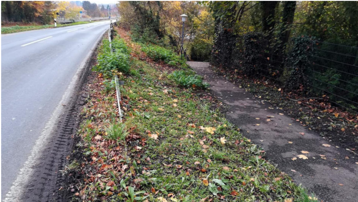
Blick von vorh. Geländezufahrt Richtung Süden. Rechts Fußweganschluss zur Treppenanlage Unter dem Hopfenberge (11.2021)
